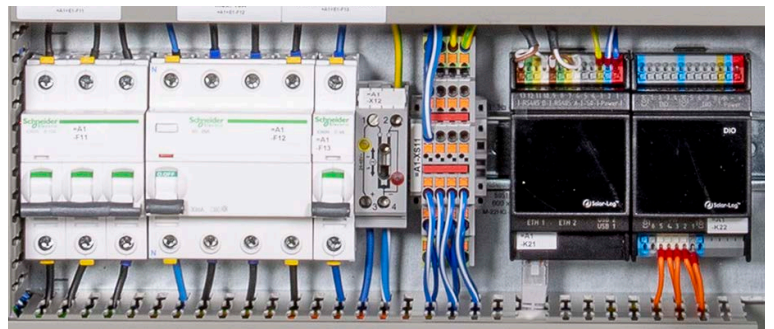
Solar-Log Base und Ziehl EFR4001IP bilden das Herzstück der Omexom PAV, E - Box.
